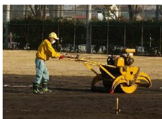
ローラーで転圧します。
