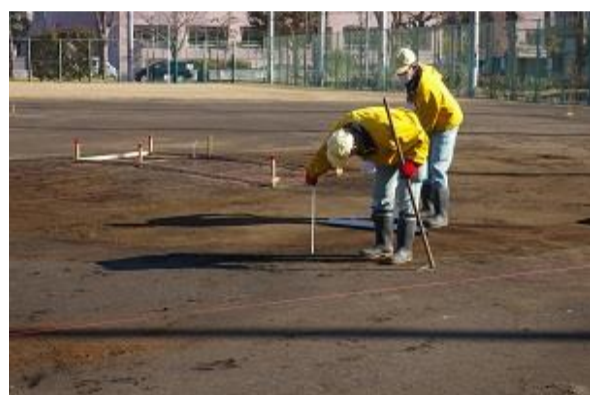
メジャーで図り高さの確認します。
