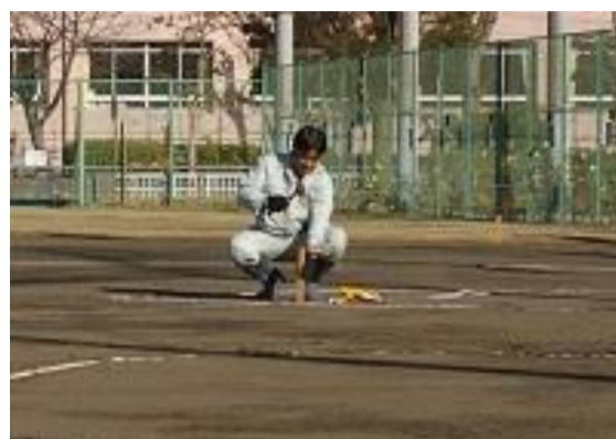
グラウンドに高さ調整の杭を打ちます。
