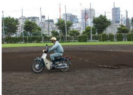
バイクでジャバラを引き整地します。
