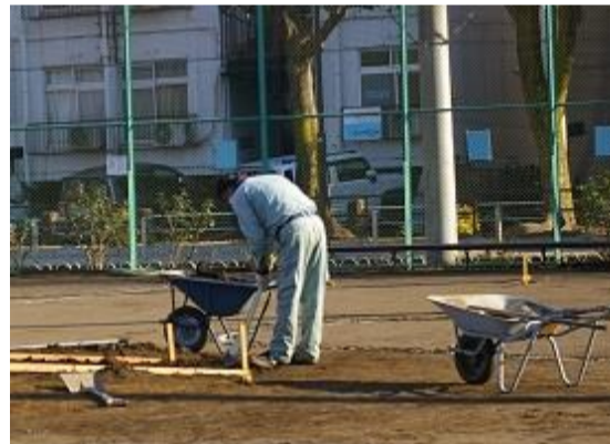
削った土を低い箇所に移します。
