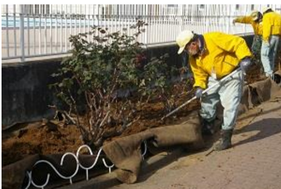
穴を埋めていきます。
