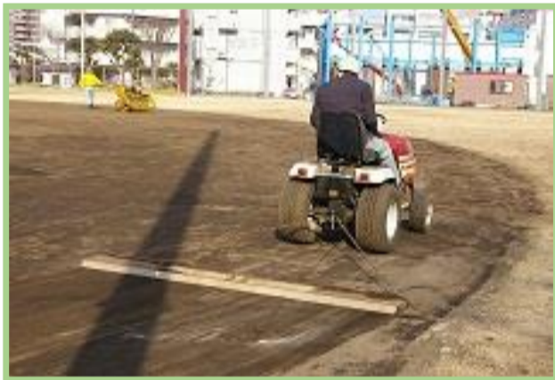
ジャバラを使いグラウンド表面を整地します。
