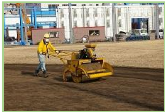
ローラーで転圧します。
