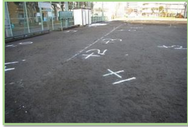
グラウンドの高い部分、低い部分を計測します。
