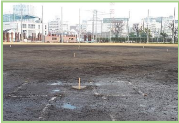
高さ調整のため杭を打ちます。
