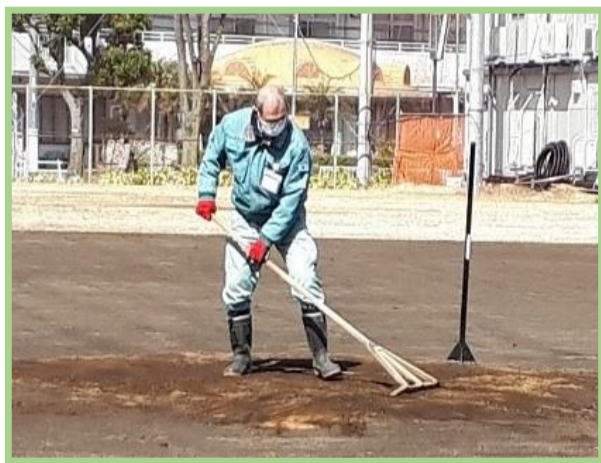
ピッチャーマウンドは手作業で整地します。
