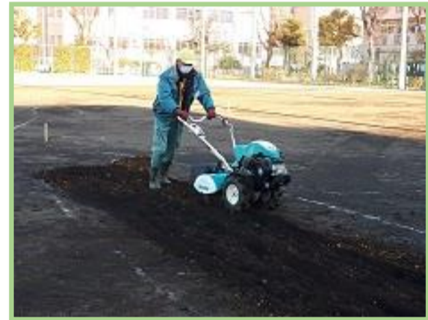
追加した土が剥離しない様に元の土に馴染ませます。
