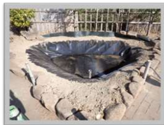
防水シート張り
