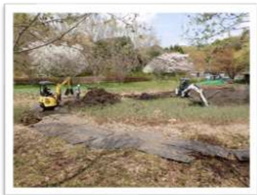
大掛かりな作業の様子
