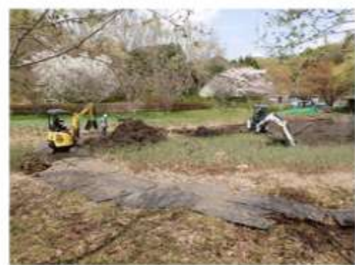
大掛かりな作業の様子
