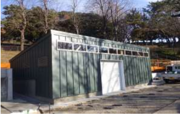
トイレ改修工事(令和4年2月1日オープン予定)
