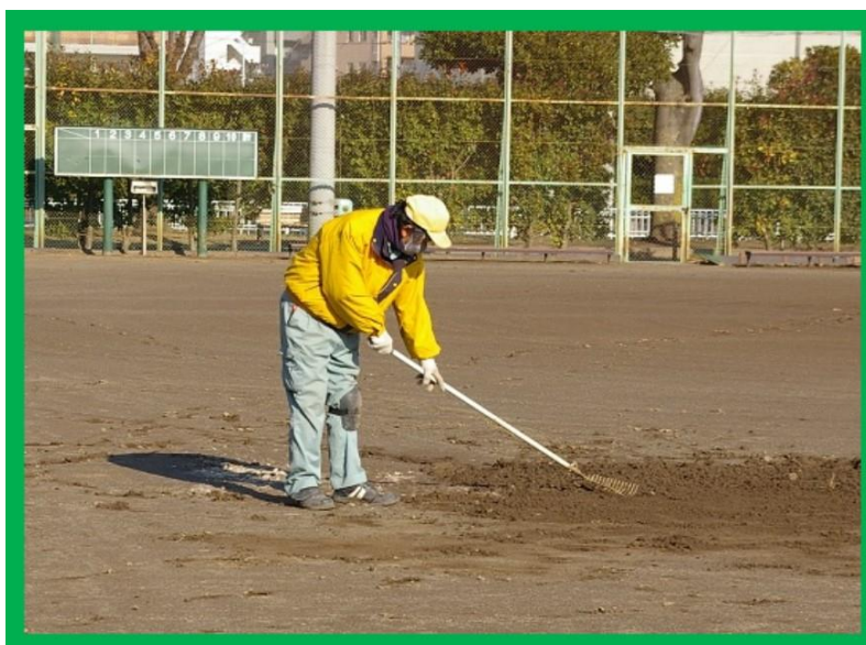
土を入れるだけでは剥離をしてしまうので下の土とよく馴染ませます。
