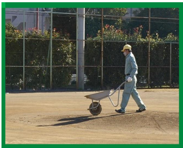
土を入れ凸凹を補修します。
