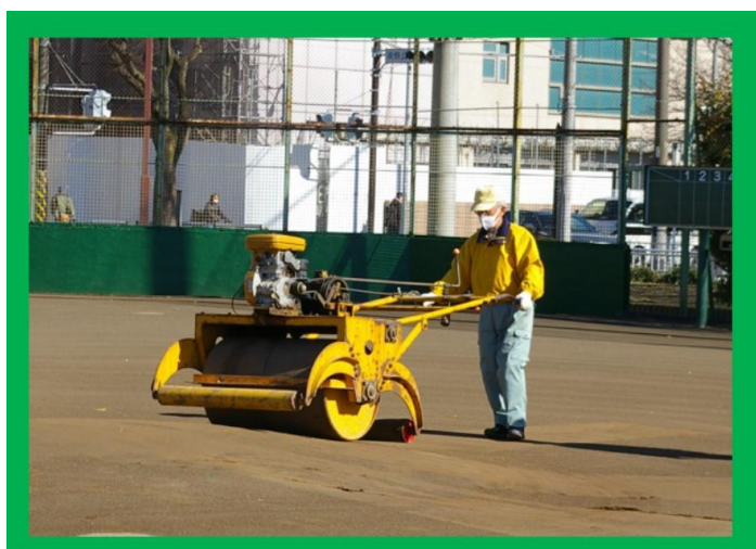
仕上げにローラーで転圧します。
