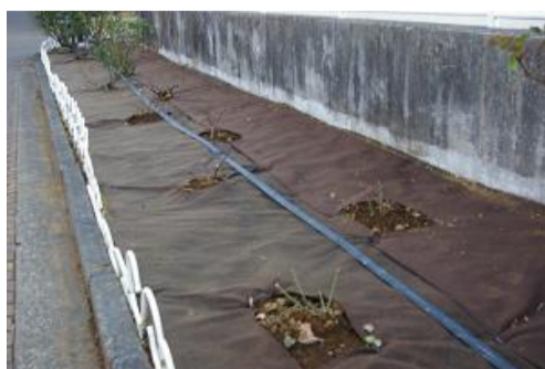
防草シートを被せ作業完了です。
