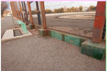
右の写真は、内側の腰壁とベンチの状態を撮りました。腰壁は衝突時の安全を保つために壁面に緩衝材を貼り、シートで覆ってあります。その塗装が劣化してすすけた状態になっていました。そこを外壁と同様に表面を掃除し、シーラーを塗布してから塗装しました。色もボールが見やすいように深緑に統一しました。
